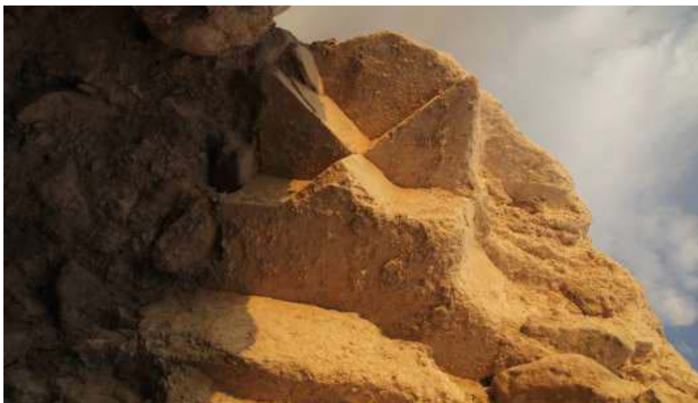
شکل ۵: مقرنس‌کاری اجرا شده بر روی ستون شماره ۶، جبهه شرقی (ولایتی ۱۳۹۹).
